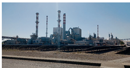
L'usine de fabrication de papier à Setúbal
